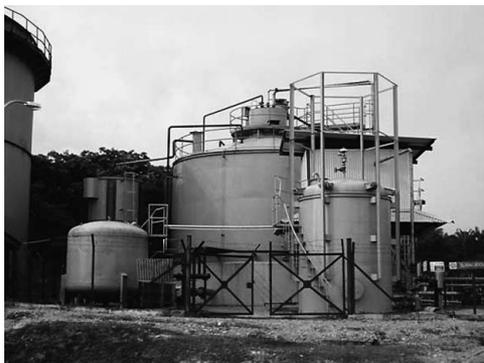
図7. Serting Hilir工場に設置された500 m<sup>3</sup>のPOMEメタン発酵パイロットプラント
